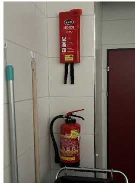
Bild 2 Löschdecke und Feuerlöscher
