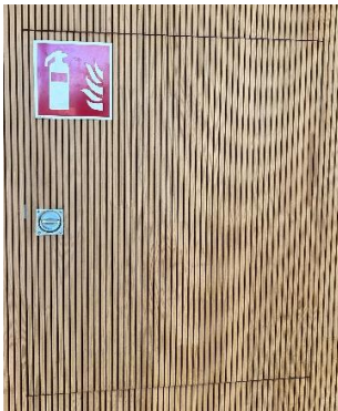
Bild 1 Wasserlöschposten
